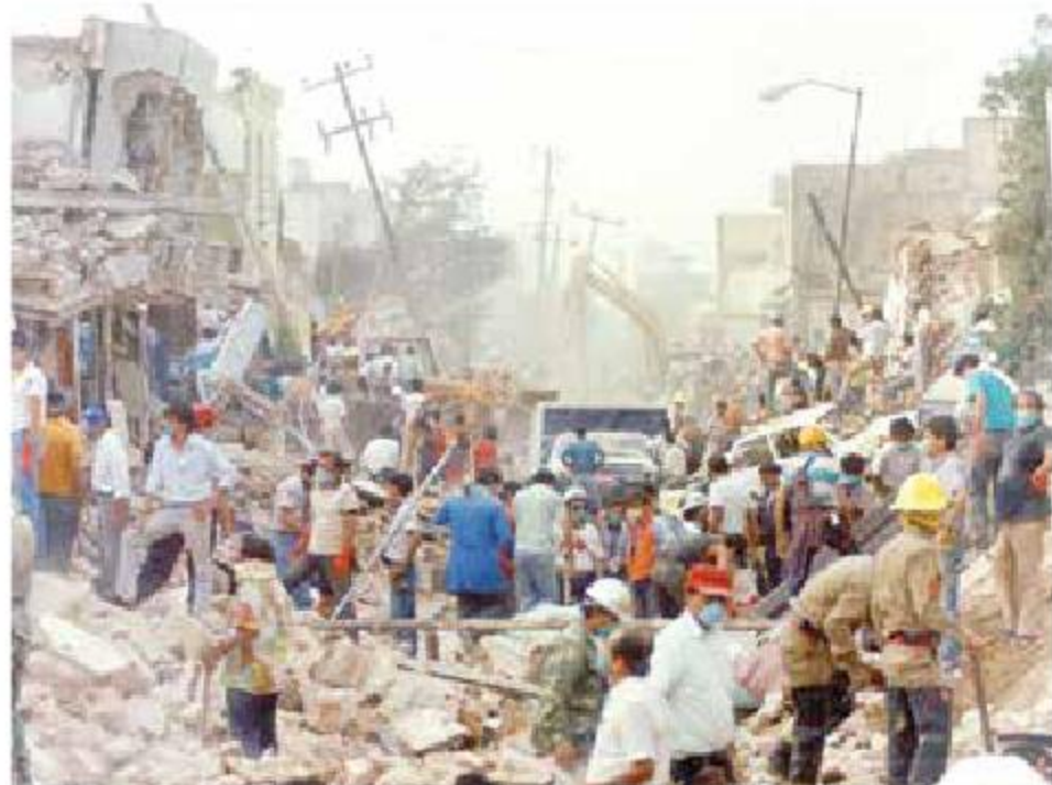
Según información oficial, las explosiones por acumulación de gas dañaron al menos 8 kilómetros de calles.
