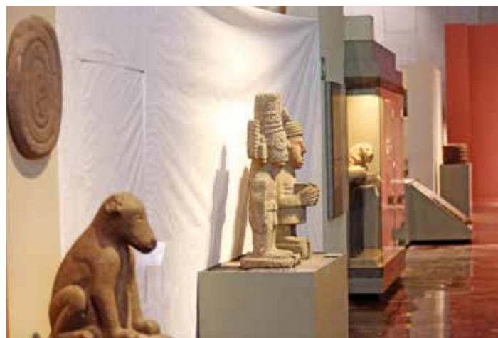
Las filtraciones hicieron su aparición el año pasado, sobre todo en la Sala Mexica. La última impermeabilización fue aplicada hace 12 años.
