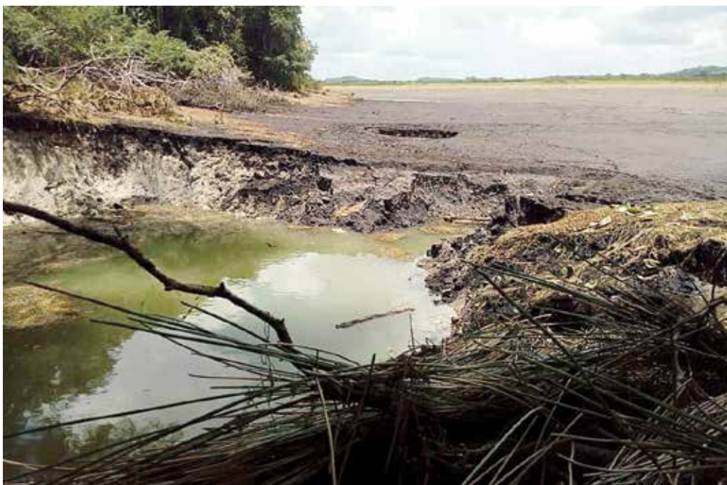
Foto: Fátima Vázquez Al fondo se observa uno de los socavones formados en la laguna Chakanbakán, que medía unos 40 mil metros cuadrados. Los cocodrilos y tortugas pudieron refugiarse en un remanso cercano.
