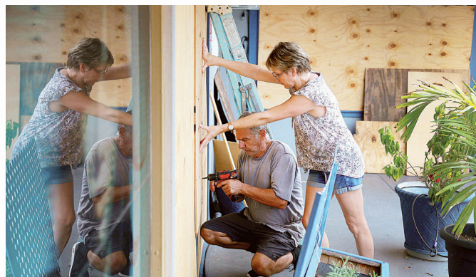
En el área de Tampa Bay, en Florida, decenas de personas bloquean puertas y ventanas para prevenir afectaciones.
