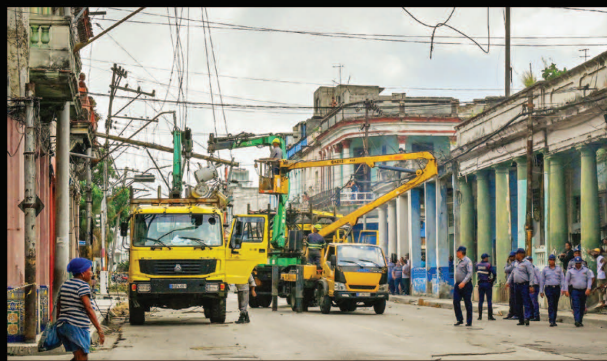
Trabajadores de la industria eléctrica asisten postes e instalaciones en el municipio de El Cerro.
